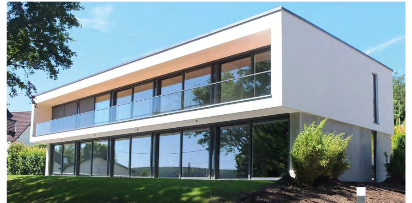
Krombacher Wohnen: Zehn Apartments © Sonntag + Partner Architekten u. Ingenieure, Siegen
