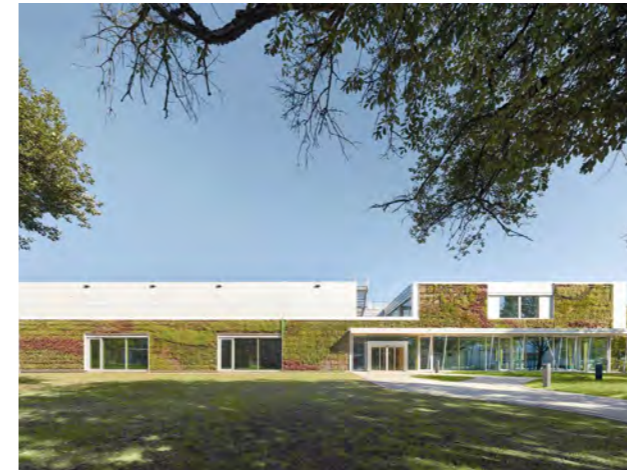
Experimenteller Holzbau: das EJOT Tec-Center in Bad Laasphe, begrünte Holzfassade und Vortragsraum
