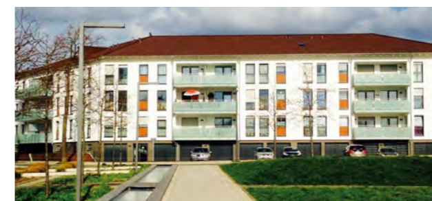
Geförderte Wohnungen in Hemer, Baujahr 2014 © Hanses.Bramey Architekten GmbH, Meinerzhagen
