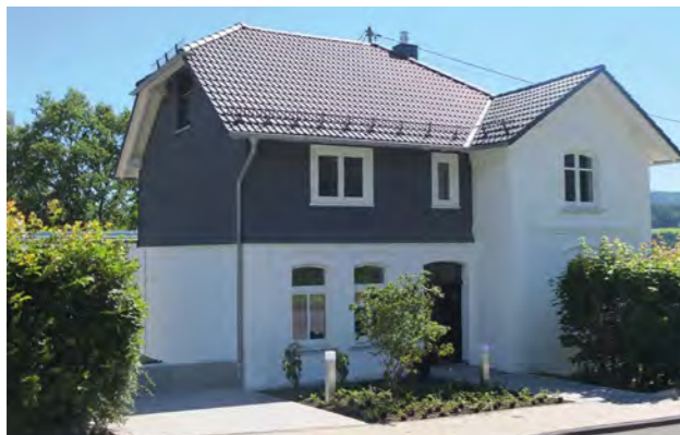
Krombacher Wohnen: Gemeinschaftsräume im historischen Haus © Sonntag + Partner Architekten u. Ingenieure, SiegenIngenieure, Siegen
