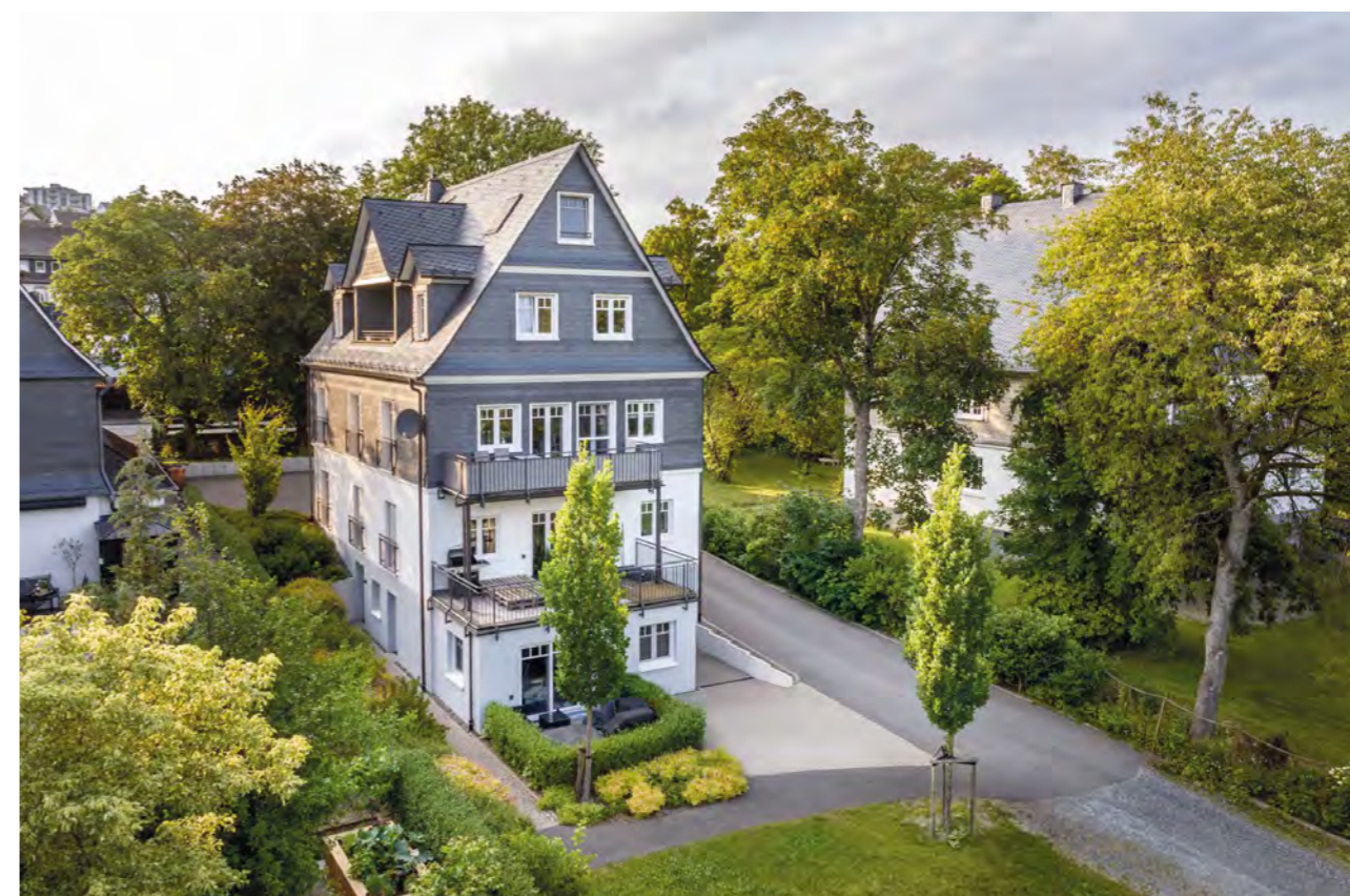
Mehrfamilienhaus in Schmallenberg, Kernsanierung durch Planungsbüro Raumzenit, Schmallenberg, Foto: © Ch. Meinschäfer
